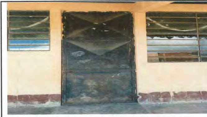
Foto 4: Sustrucion de Vidrios y ventanas
