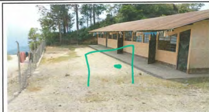
Foto 1: Sustrucion de lamina, por laminas troqueladas calibre 26 aluzinc
