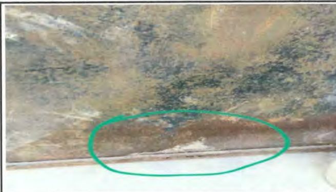
Foto 2: Mantenimiento a estructura (fijado, cambio de ubo, cepillado y aplicado de pintura).
