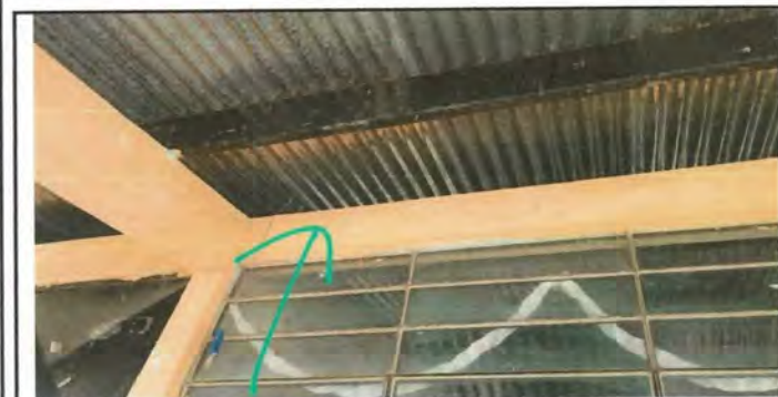
Foto 5: Mantenimiento a estructuras de metal de ventanas
